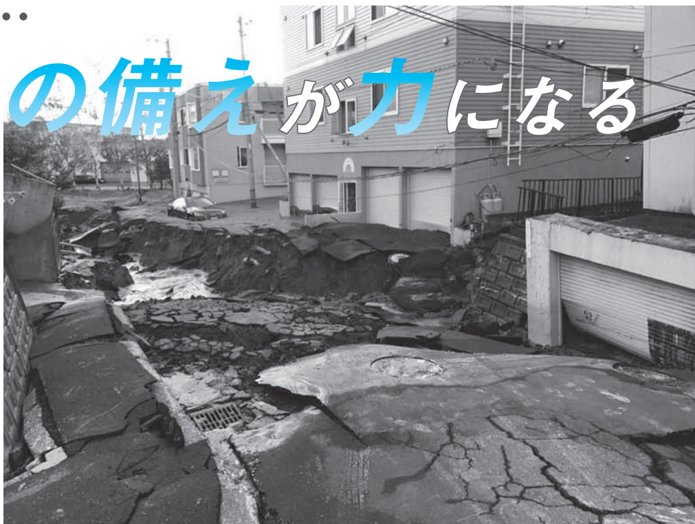
地震が原因で札幌市で起こった液状化現象による道路の陥没
