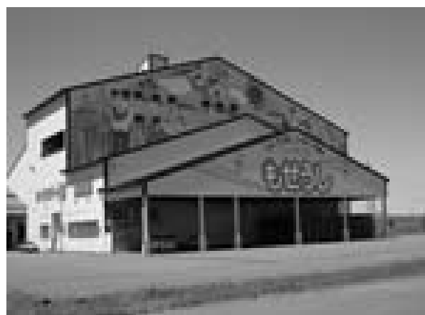
▲米穀乾燥調製貯蔵施設
