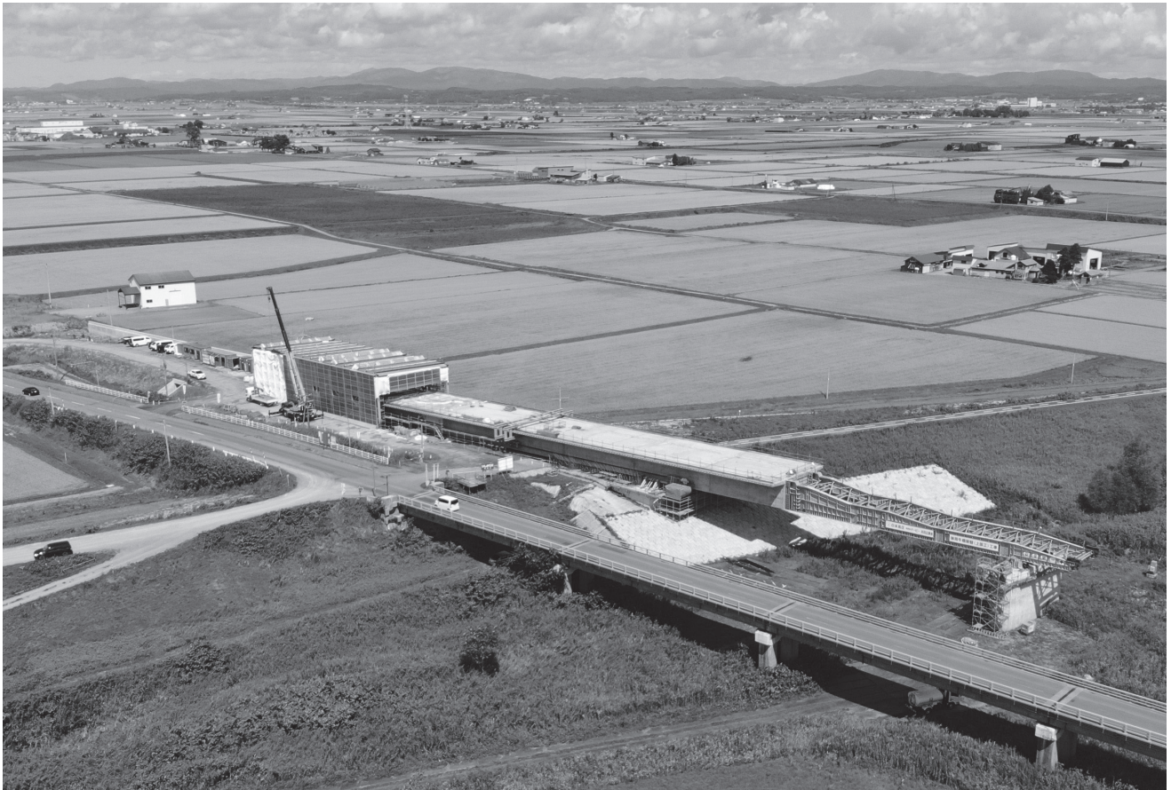
▲架け替え工事が進められている妹背牛橋
