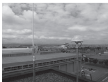
△役場屋上に設置されたアンテナ GNSSアンテナ（左）GPS（右）
