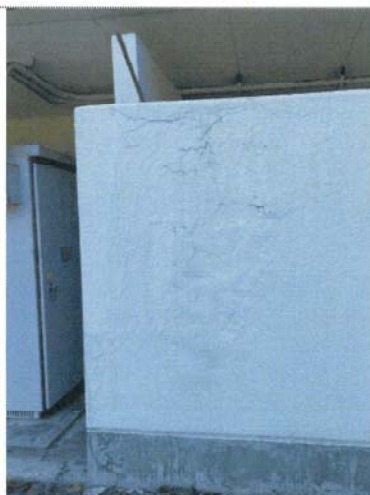
校舎内壁（ひび割れ）
