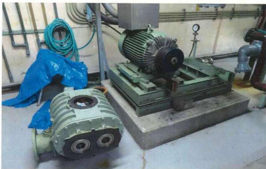
曝気ブロワ・電動機交換
